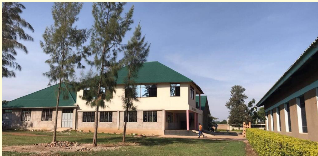
Kjøkken og kantine ved skolen
